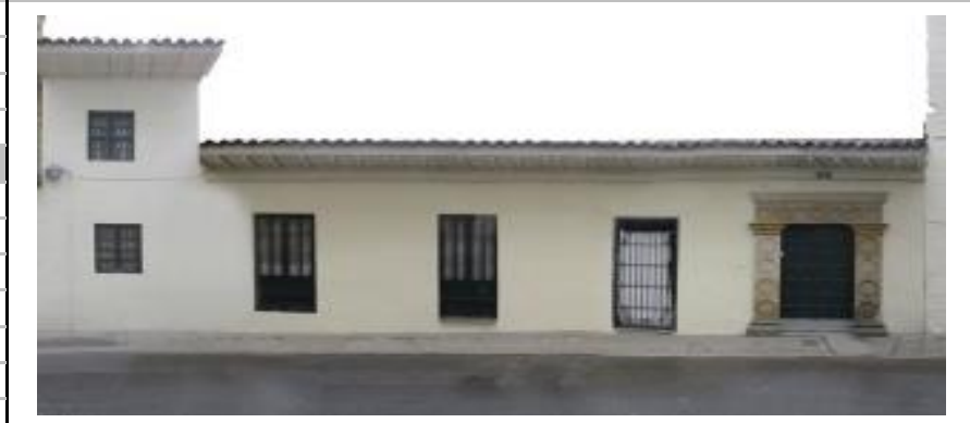
Fuente: Equipo Fotografía PEMP Patrimonio Inmueble
